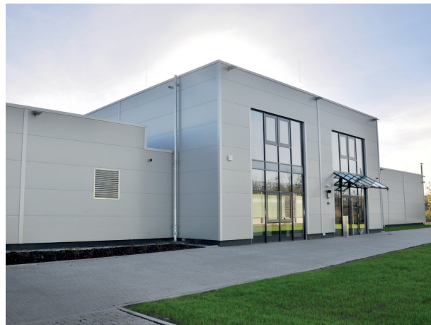
01 Außenansicht des neuen Rechenzentrums
