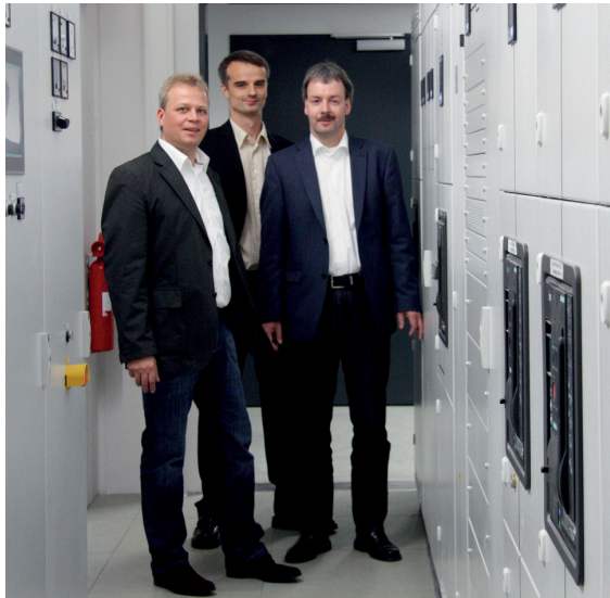
04 Olaf Dieckmann von Röwer Sicherheits- und Gebäudetechnik sowie Andreas Pahl und Christian Müller von Kesselhut Schaltanlagen (v.l.n.r.)
