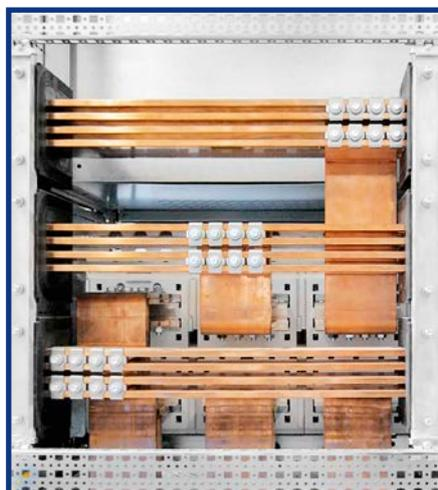
Hauptsammelschiene (Ansicht von hinten).
